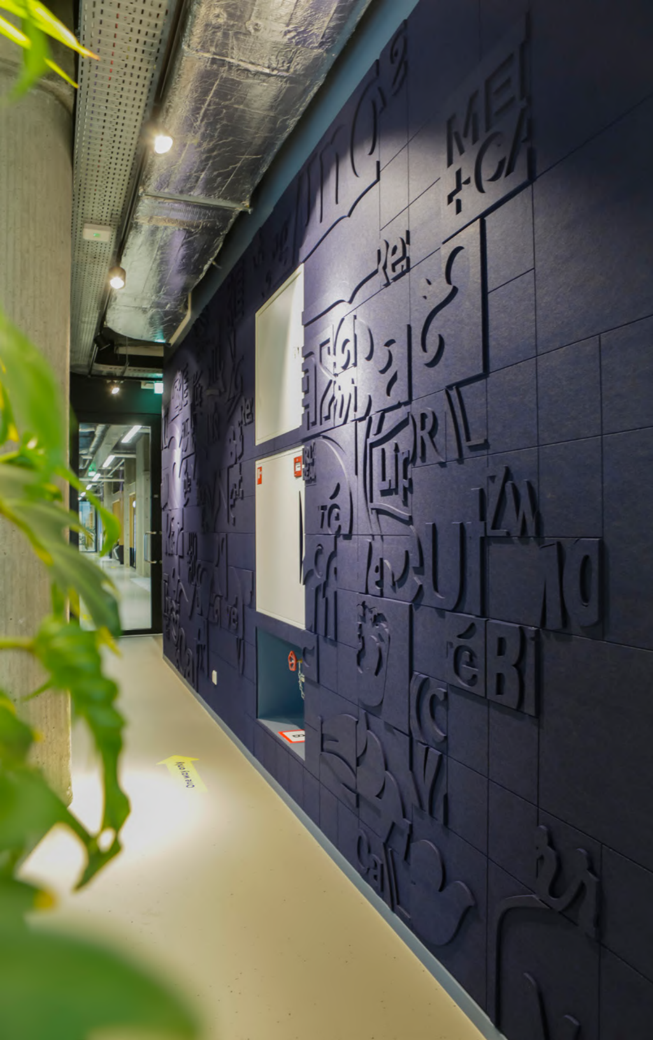
Project: PET Felt wandbekleding voor Unilever, Rotterdam Ontwerp: Silo Creative Agency, Den Haag Fotografie: Stephan Wor
